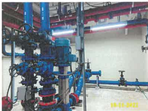
เครื่องสูบน้ำ (Cold Water Pump)
